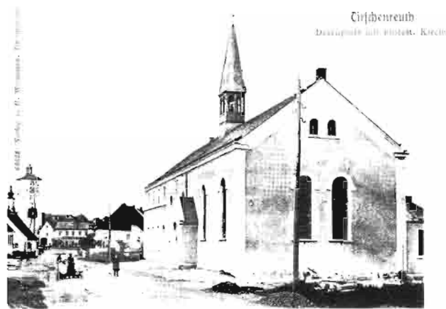
... und nach dem Umbau zur Kirche.
