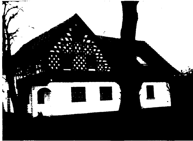
Hatzenreuth, Stadt Waldsassen, Landkreis Tirschenreuth. Ehemaliges Wohnstallhaus mit Umshrot, Frackdach und Fachwerkgiebel aus der 2. Hälfte des 18. Jahrhunderts. Fachwerkgiebel mit aufwändigem Fachwerk aus fächerförmig angeordneten Streben, dichtem Rautengitter und Ziergiebelchen.
