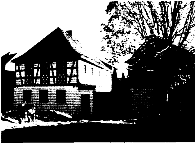
Markt Mähring, Landkreis Tirschenreuth, Wohnstallhaus mit Walmdach, massivem Erdgeschoss und Fachwerk im Obergeschoss um 1769. Fachwerk mit Ständer- Riegel Konstruktion mit geschosshohen Streben, Brüstungsfelder mit Andreaskreuzen und Viertelkreisen geschmückt. Das Hauptgebäude erinnert an einen barocken Haustyp, wie er vor allem in Oberfranken vorkommt.
