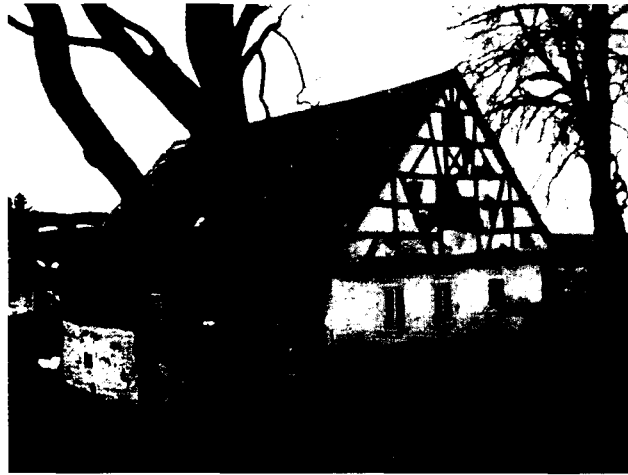
Bild links: Markt Neualbenreuth, Landkreis Tirschenreuth. Satteldachbau mit Blockbau im Erdgeschoss und Fachwerk im Obergeschoss, um 1755.
