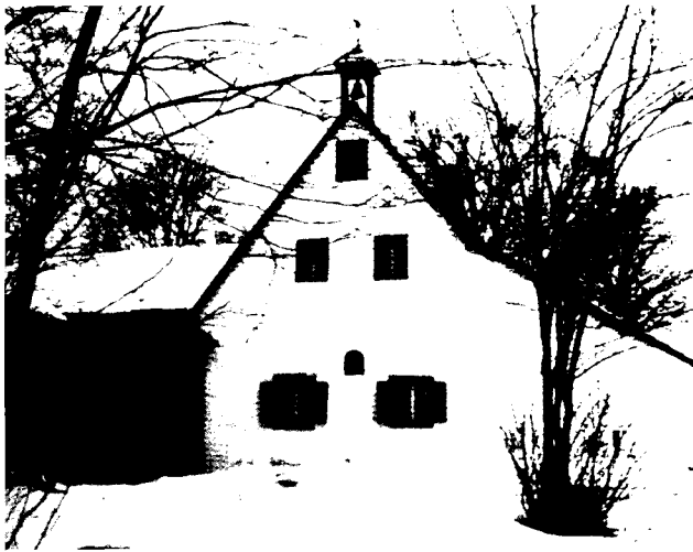
Kleinklenau, Stadt Tirschenreuth, Landkreis Tirschenreuth. Dreieckshof mit erdgeschossigem massivem Wohnstallhaus mit Satteldach und Dachreiter aus der 1. Hälfte des 19. Jahrhunderts. Die nördliche Giebelseite ziert eine Nische für eine Heiligentür.
