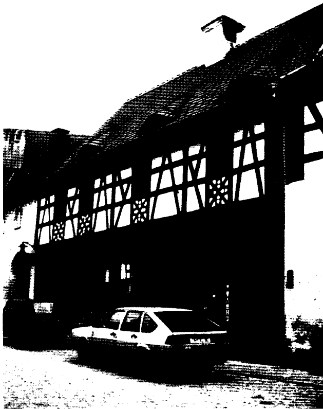
Bild links: Markt Neualbenreuth, Landkreis Tirschenreuth. Satteldachbau mit Blockbau im Erdgeschoss und Fachwerk im Obergeschoss, um 1755.
