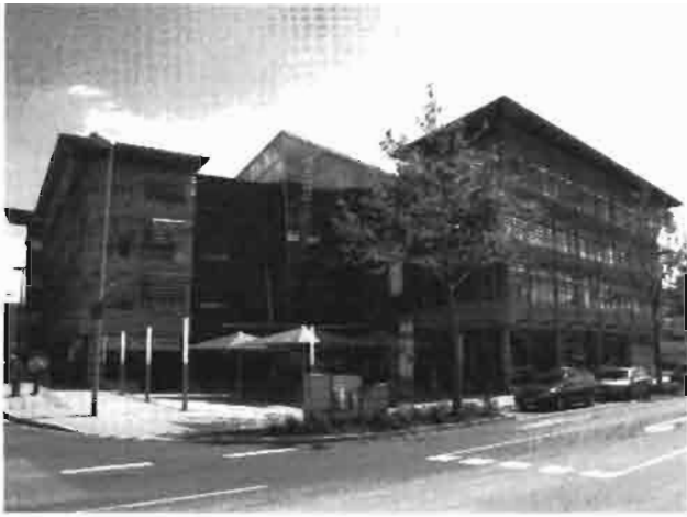
Ansicht der heutigen „Emailfabrik“ ( www.emailfabrik.de )
